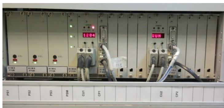
نمایی از HIMA Redundant CPU's
